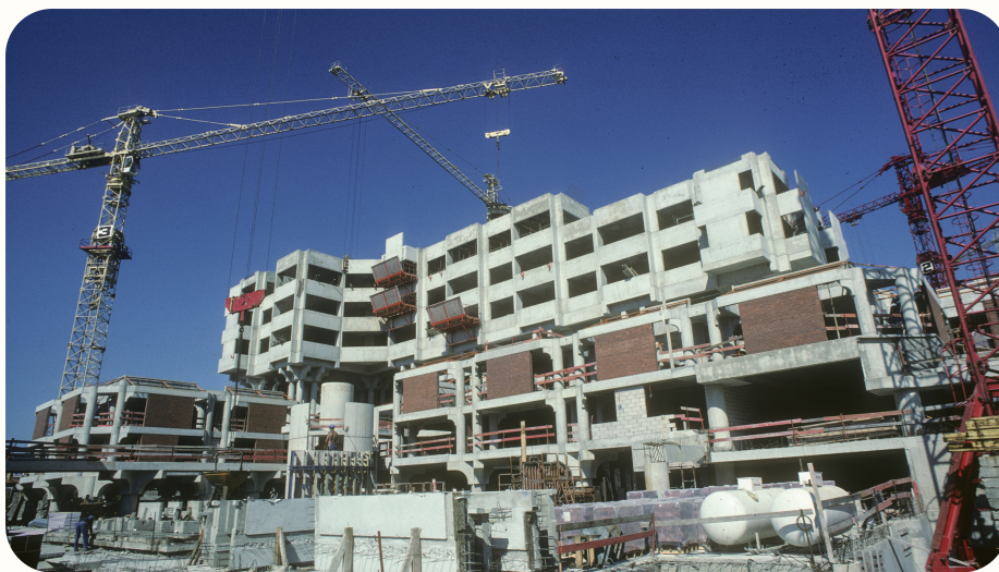
Le Palais de Justice de Bobigny en construction © Archives communales de Bobigny
